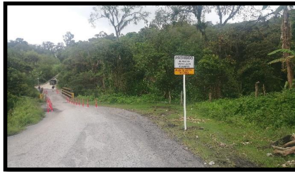
Señalización vertical via alterna
