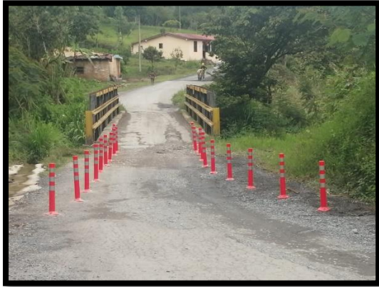
Hitos para restriccion de paso sobre el puente
