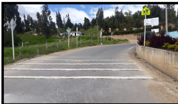
Señalización vertical y horizontal Cuitiva
