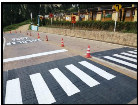
Señalización vertical y horizontal Cuitiva
